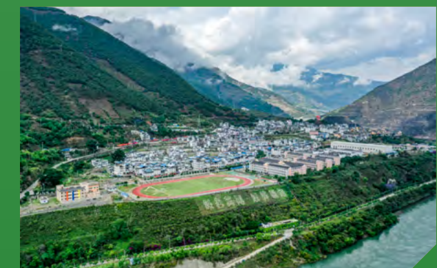
苗尾电站道路边坡治理成效
