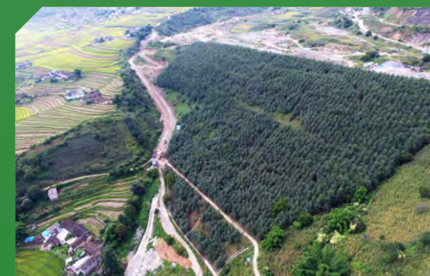
苗尾电站丹坞堑渣场边坡植被恢复
